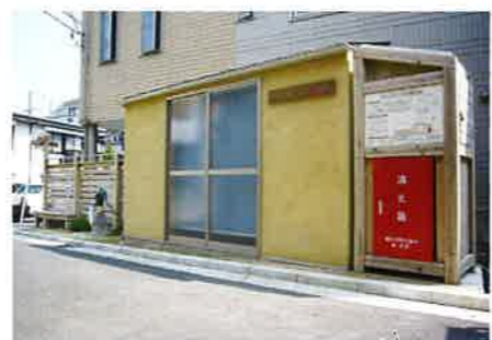
地下貯水槽と手押しポンプ
